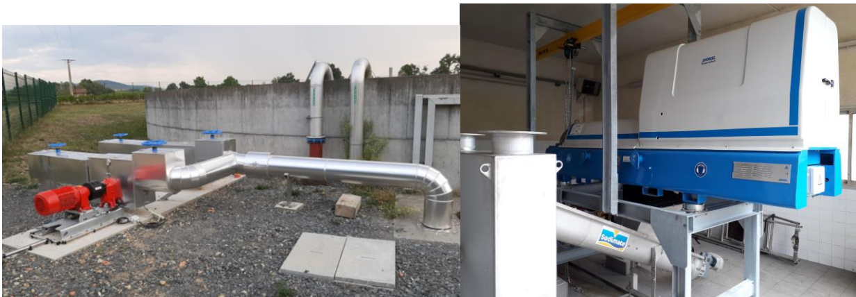
Figure 29 : Travaux de la station d'épuration de St Etienne des Oullières
